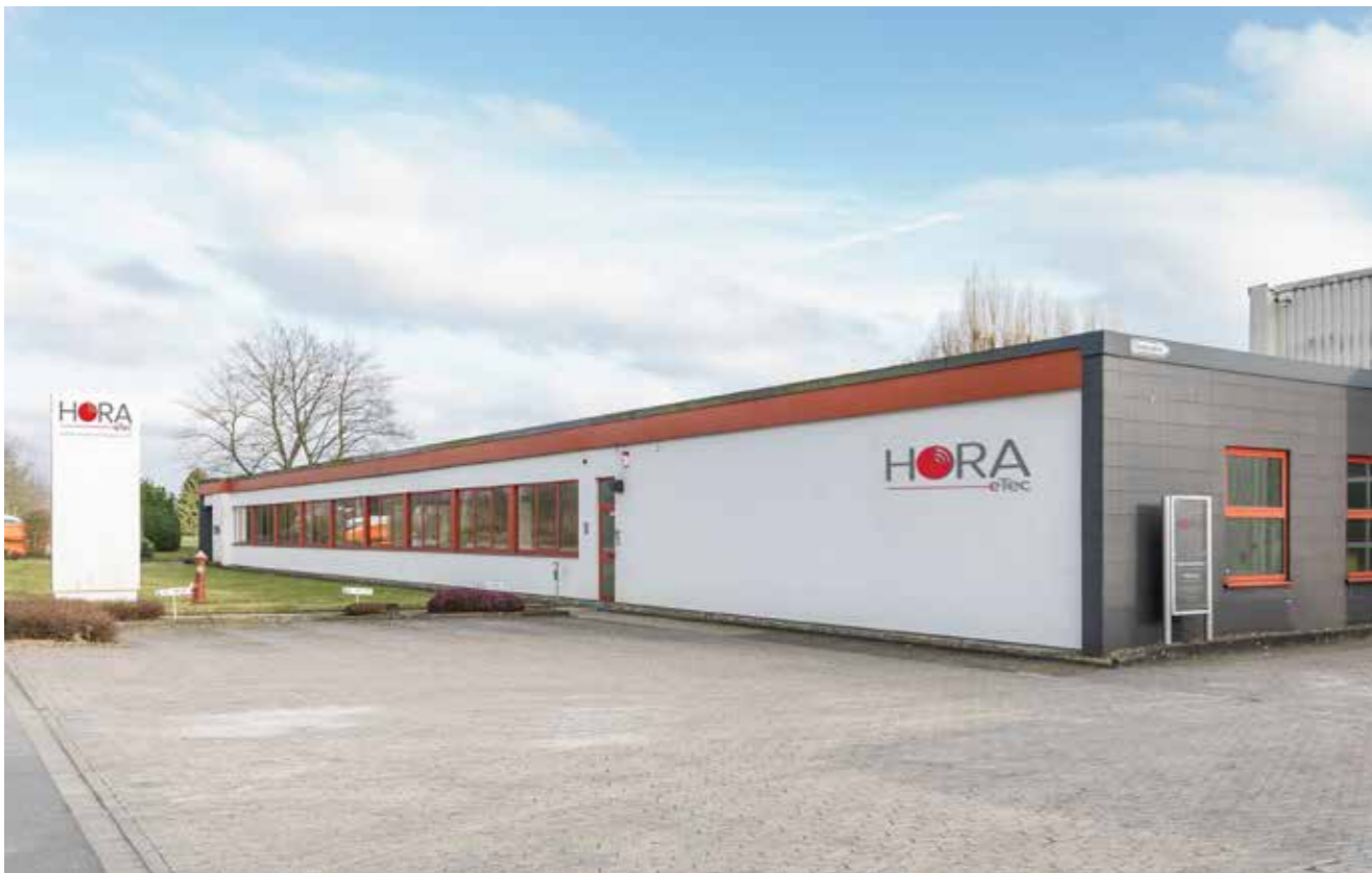
HORA eTec GmbH – Werk Grabenstraße
